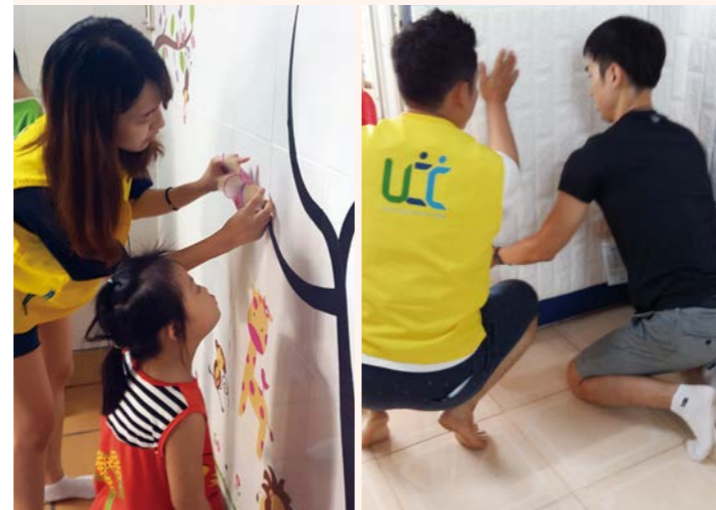
충돌 안전 사고 방지를 위한 폼볼력 벽지 시공
