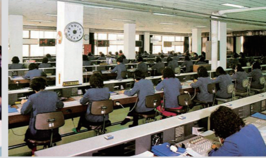
ESS 기계실 모습 및 국제자동전화(ISD) 개통 및 무선호 출서비스의 도입 초창기에 사용된 호출기들
